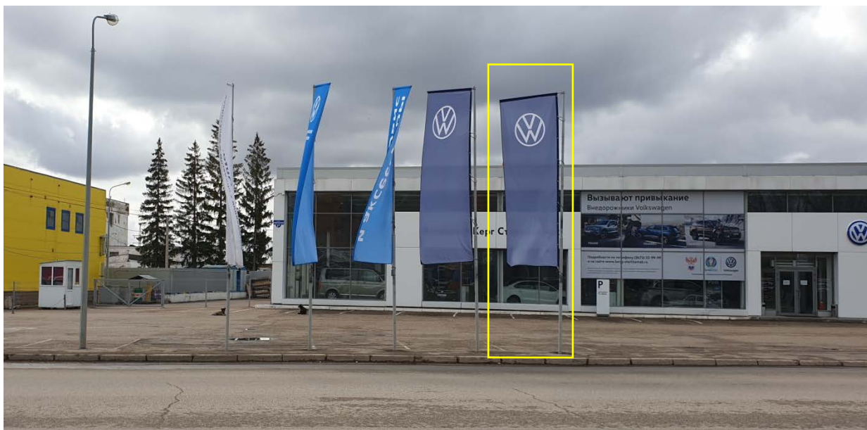
№ Ф – 26, г. Sterlitamak, около нежилого здания по ул. Профсоюзная, 1 (литер № 5)
